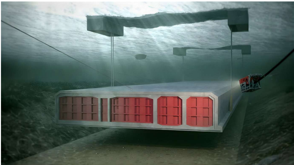
Bild 4: Bauart: Absenktunnel Bauweise: 79 Standard-Tunnelemente: je 217 m lang, 42 m breit, 9 m hoch, 73.000 t schwer. Die ersten Elemente werden 2026 auf der dänischen Seite abgesenkt. Tunnelgraben fertig ausgehoben: ca. 12 m tief, ca. 100 m breit, 15 Mio. m 3 Aushub. (c) Femern S/A
