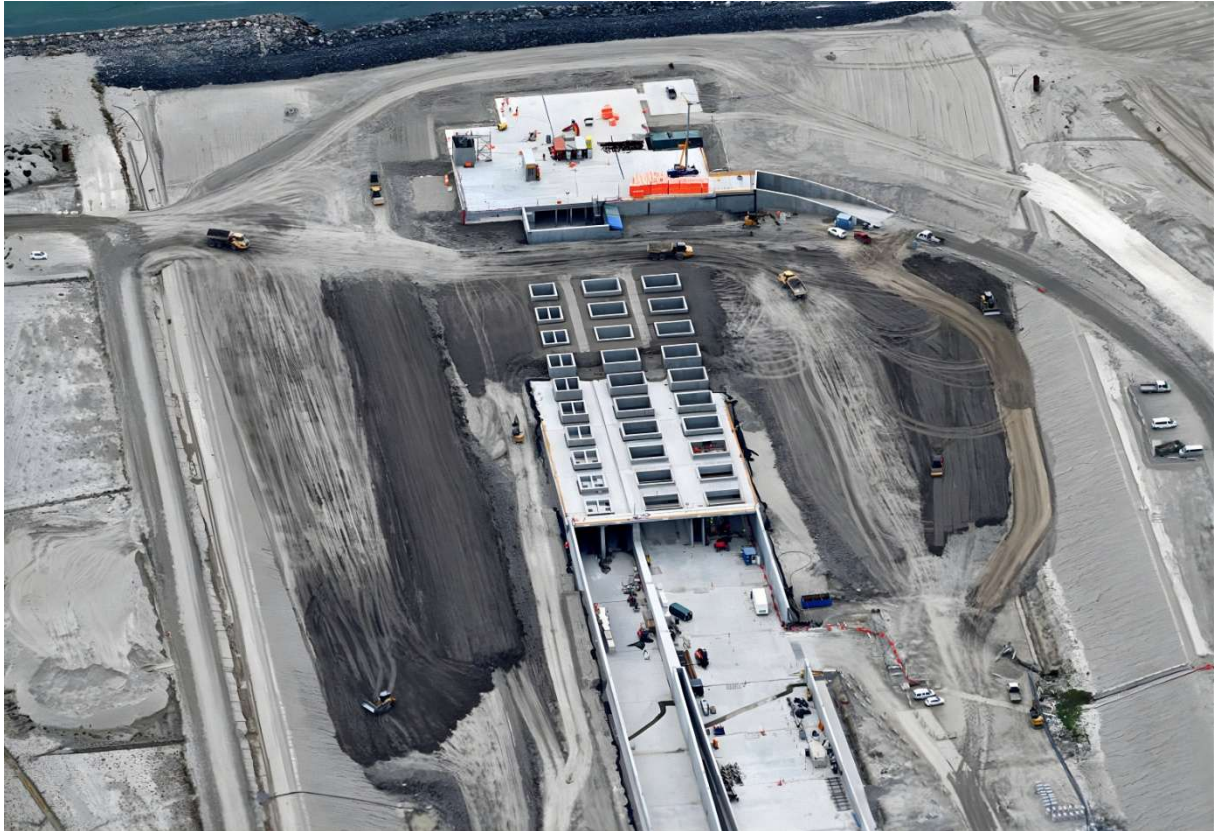
Bild 5: Am dänischen Tunnelportal hatten die Arbeiten Anfang Mai 2022 begonnen. Mittlerweile sind die Betonagen für den Tunnelabschnitt in offener Bauweise abgeschlossen. Auch die Lichtübergangszone an der dänischen Tunneleinfahrt ist hergestellt. Sie wird für einen sanften Übergang der Lichtverhältnisse während der Fahrt durch den fertigen Tunnel sorgen. Deutsche Baufirmen u. a. Wayss & Freytag und Max Bögl sind am Bau beteiligt. (c) Femern S/A
