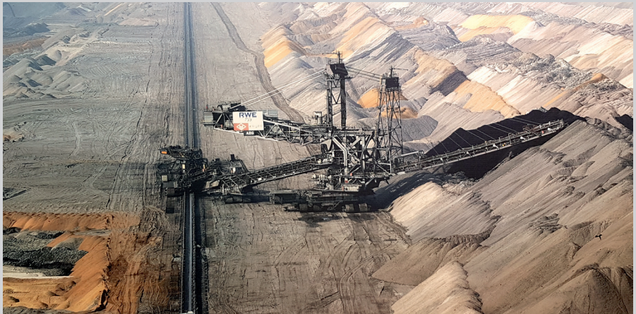
Schaukelradbagger im Tagebau Garzweiler bei der Arbeit
