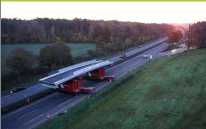
Die Schnellbaubrücke unterwegs
