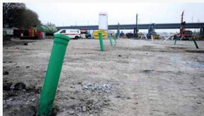
Mit 200 Sonden wird das zukünftige ICE-Werk am Dortmunder Hafen geothermisch beheizt
