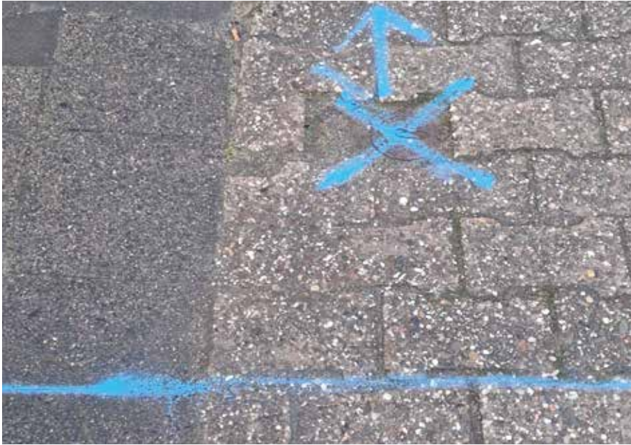
Abb. 1: Verortung des Wasserrohrbruches
