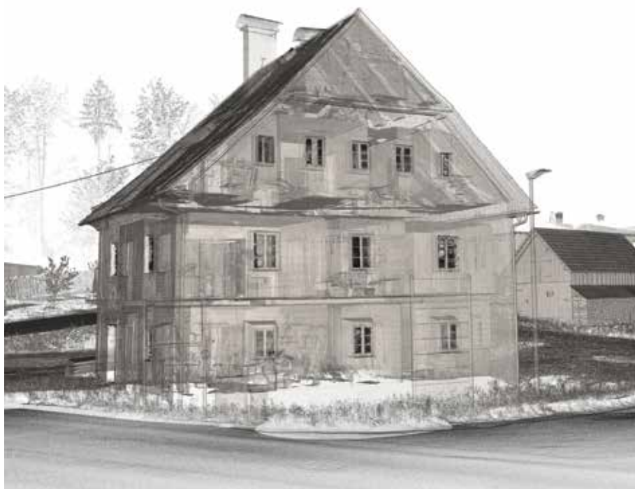
Datenerfassung des Hauses des ehemaligen Talsperrenbetreibers in Hallstatt mit dem RIEGL VZ-600i
