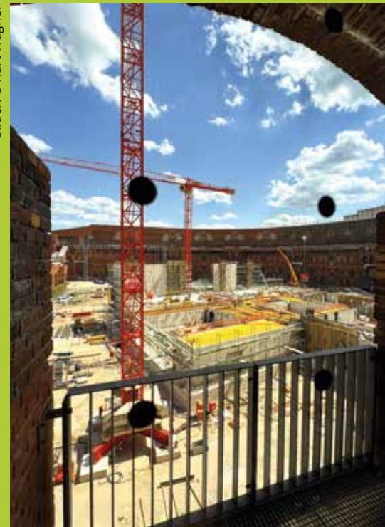
Rohbau zukünftige Spielstätte Staatstheater
