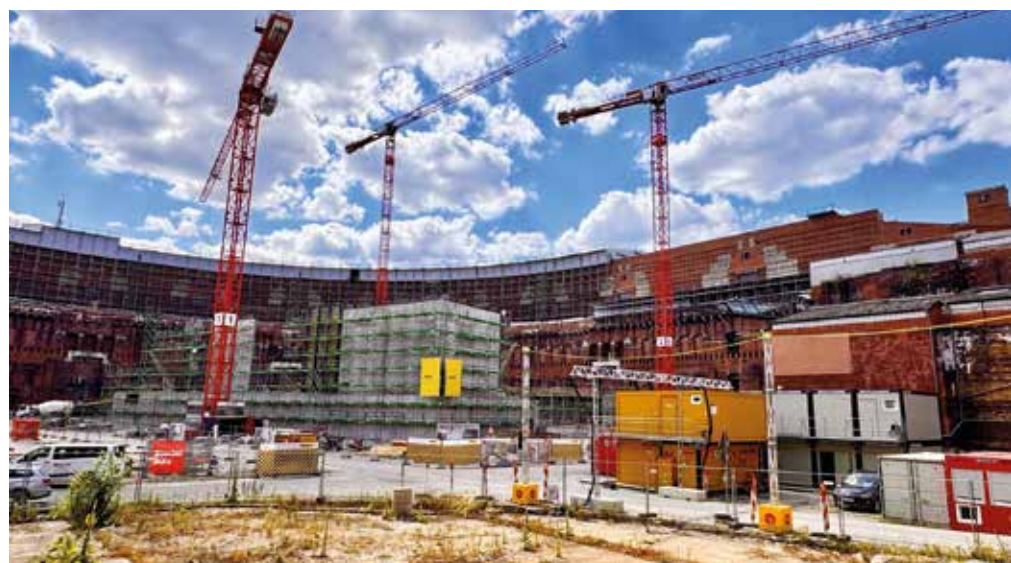
Rohbau zukünftige Spielstätte Staatstheater
